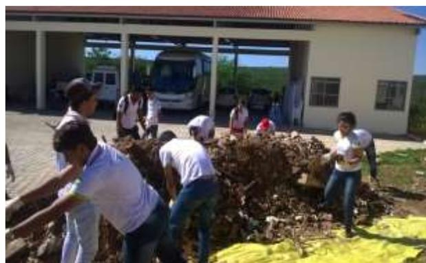
Figura 04: Separação de RCD's para Classificação/Foto: Maria do Socorro
