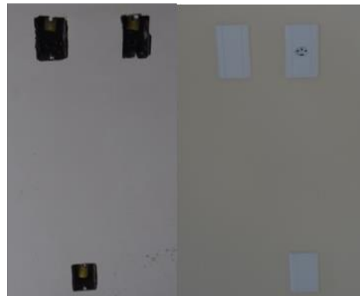
Figura 4 - Instalação de TUG's na sala: Visita Técnica.
